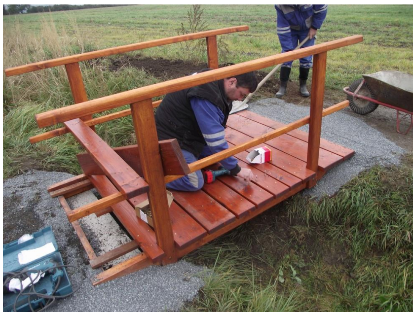
Obr. 17: Instalace mostku v Horoušánkách
