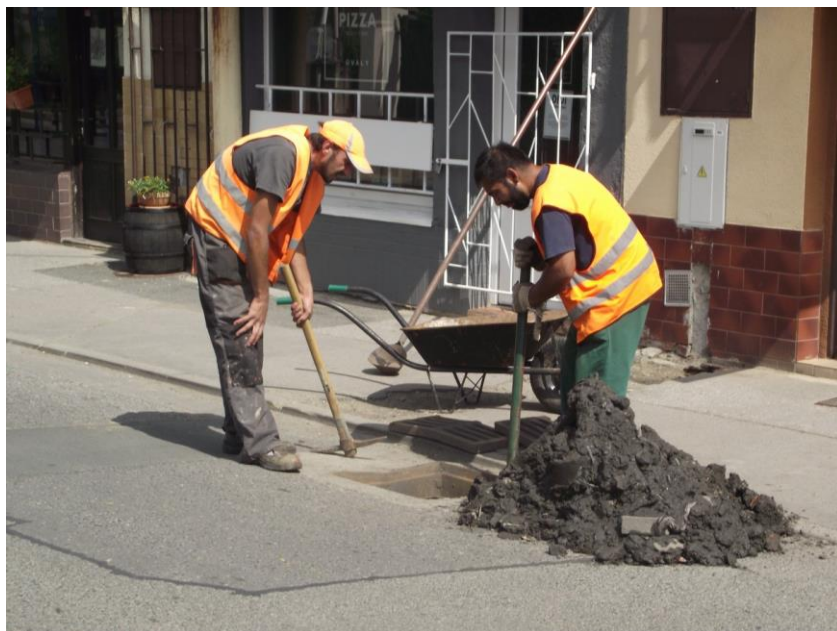
Obr. 17: Čištění dešťových vpustí
