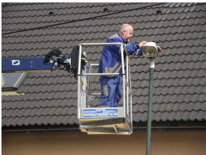
Obr. 15: Oprava lampy
